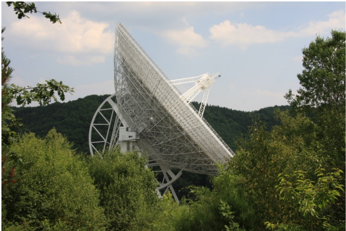
Bild 12: Radioteleskop Effelsberg mit Antennendurchmesser von 100m, betrieben vom Max-Planck-Institut
